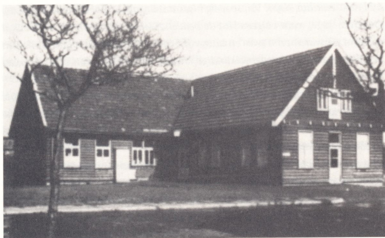
Afb. 30. De 'tyfusbarak' op het terrein van het AZG
